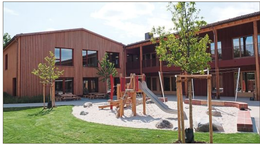
... der Kindergartenbau Haus 2 mit Gestaltung der Ortsmitte. Fotos: Monika Ebnert
