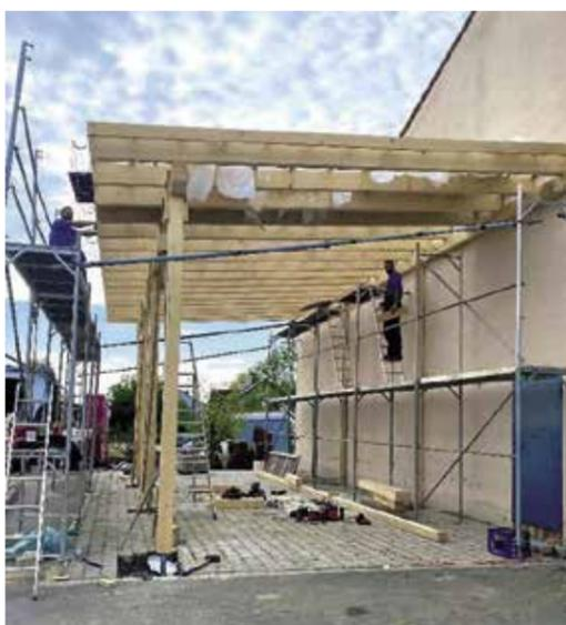
Ein Carport wurde an der Bauhofhalle errichtet, um Materialien und Geräte vor der Witterung zu schützen. Bild: Zimmerei Salihu aus Mamming bei der Ausführung
