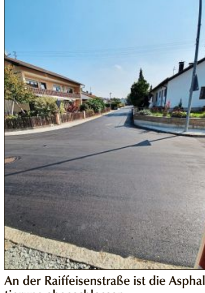
An der Raiffeisenstraße ist die Asphaltierung abgeschlossen.
