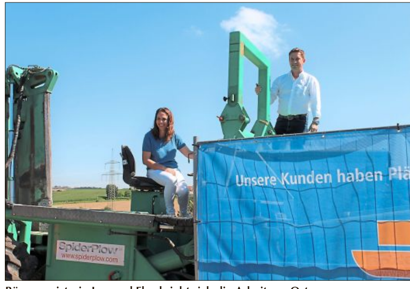
Bürgermeisterin Irmgard Eberl sieht sich die Arbeit vor Ort an.
