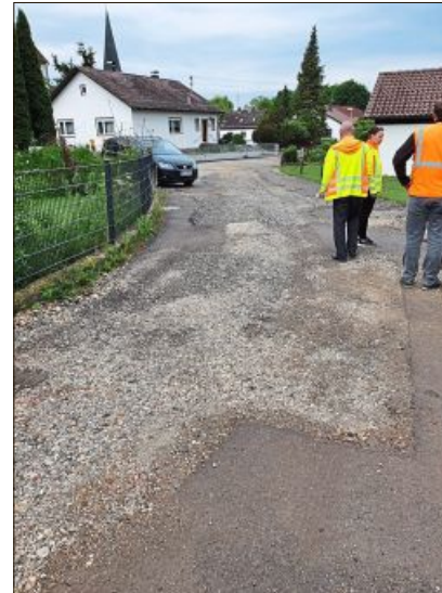
Der Baufortschritt in der Raiffeisenstraße.
