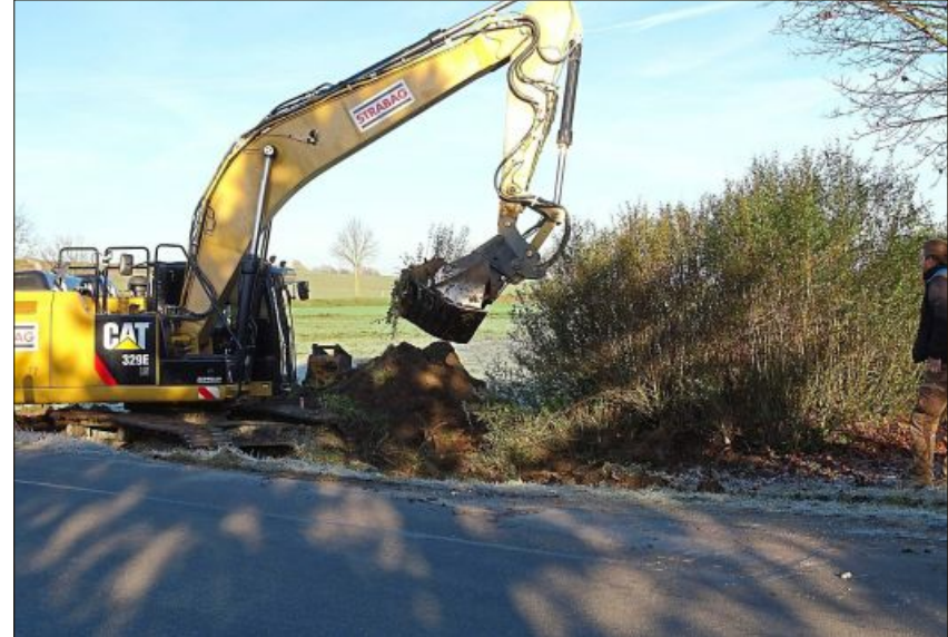
Der Bagger vollzieht die ersten Erdbewegungen.
