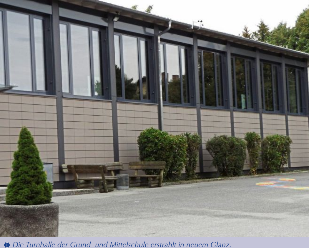
◆ Die Turnhalle der Grund- und Mittelschule erstrahlt in neuem Glanz.
