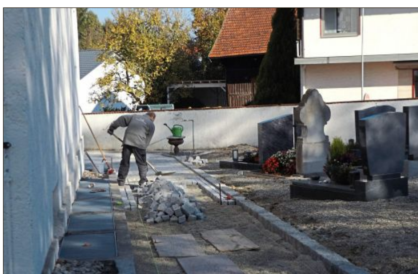
Bald werden die Pflasterarbeiten beendet sein.
