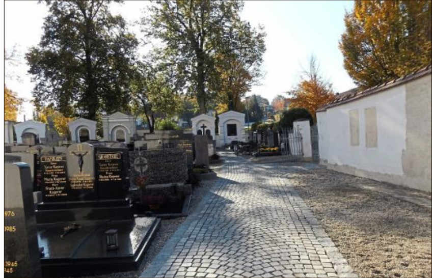
Der fertiggestellte Teil der Pflasterarbeiten.
