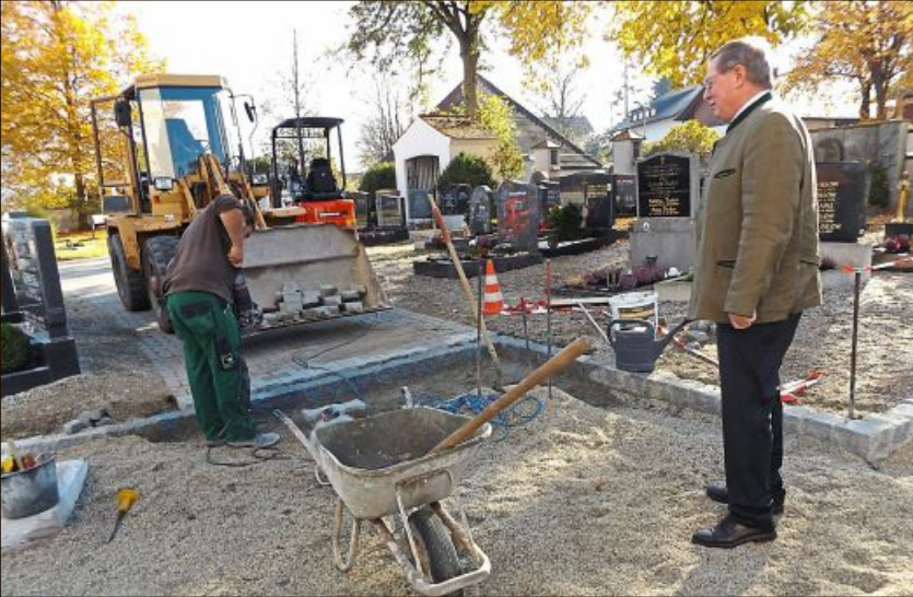
Bürgermeister Eberl inspiziert den Fortschritt der Pflasterarbeiten.
