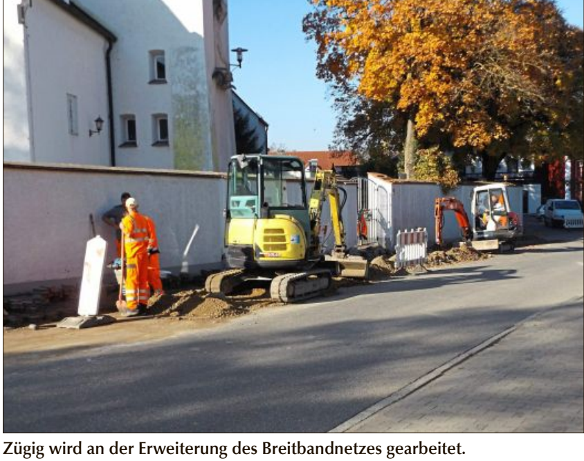
Zügig wird an der Erweiterung des Breitbandnetzes gearbeitet.
