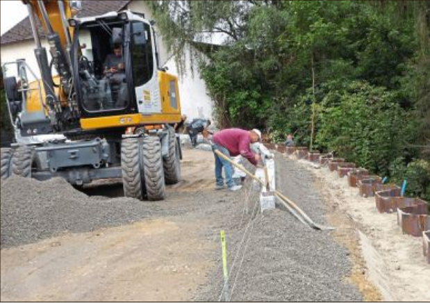
Spundwand und Randsteine wurden verbaut.
