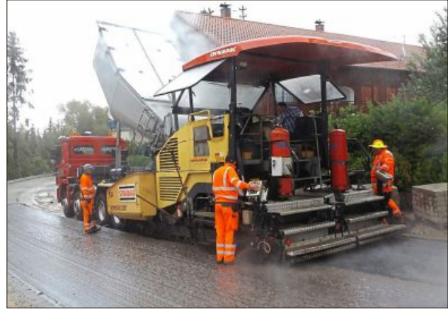
Beim Aufbringen der Asphalttschicht.
