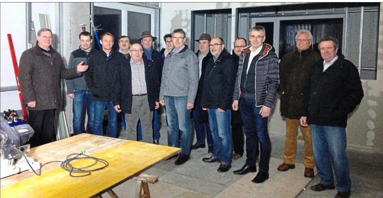
Der Gemeinderat besichtigt die Baustelle des Feuerwehrgerätehauses.
