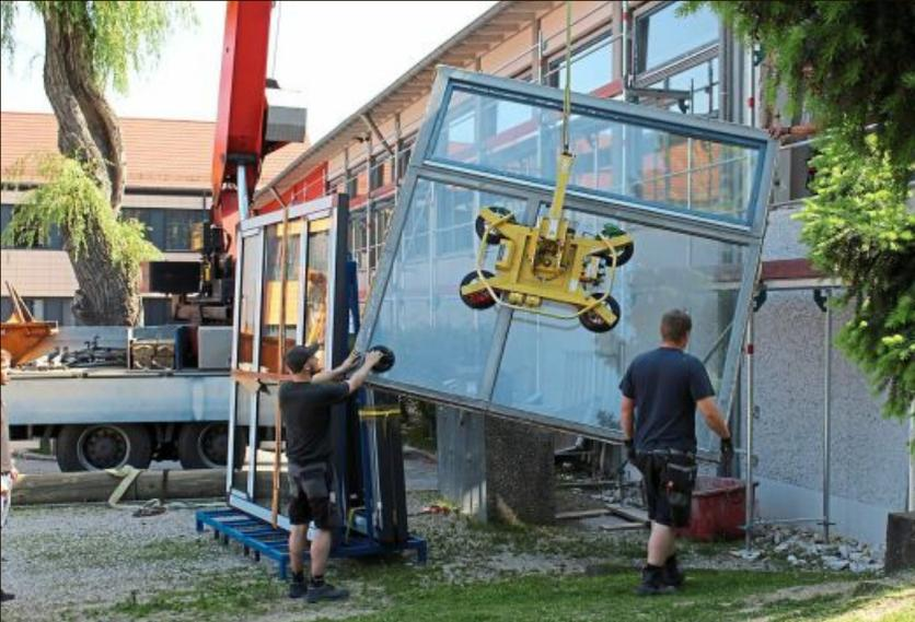
Die alte Fensterfassade der Mamminger Turnhalle wird durch hochwertige Fenster ersetzt, die durch eine moderne elektrische Steuerung die Möglichkeit einer optimalen Belüftung und Beschattung bieten.
