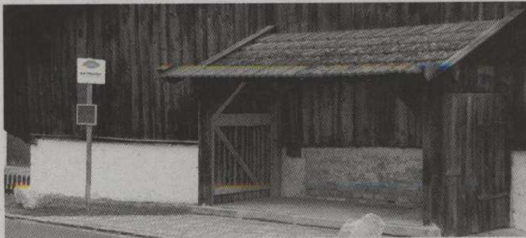
Die Schulkinder sind nun vor Regen geschützt.
