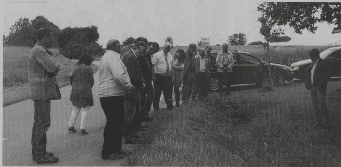
Der Bau- und Umweltausschuss des Landkreises besichtigte vor seiner Sitzung die schadhafte Kreisstraße bei Pilberskofen.
