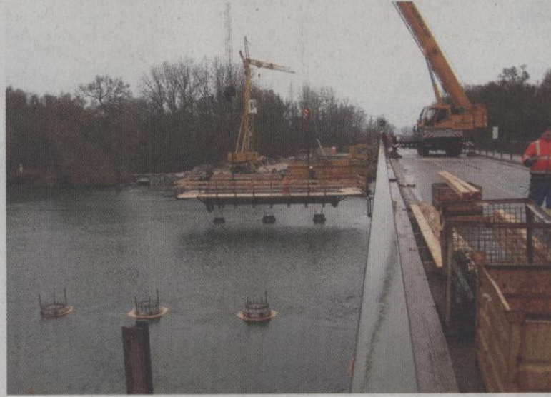
Ein Blick auf die Baustelle.
