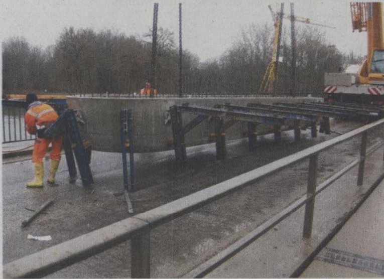
Die großen Stahlbetonfertigteile wurden eingebaut.
