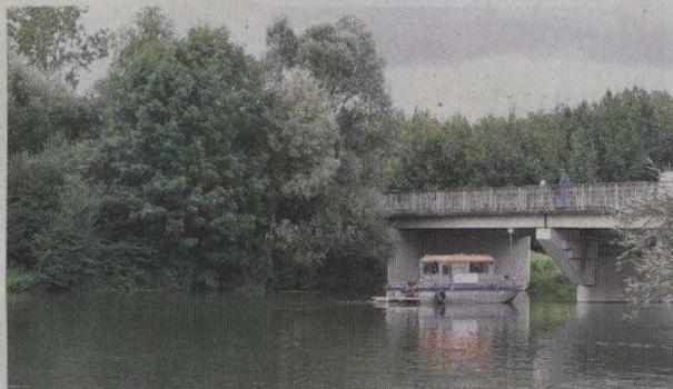
Von einem Boot aus wurden Echolotmessungen durchgeführt, um eine Bauzustandsanalyse der alten Brücke zu erstellen.
