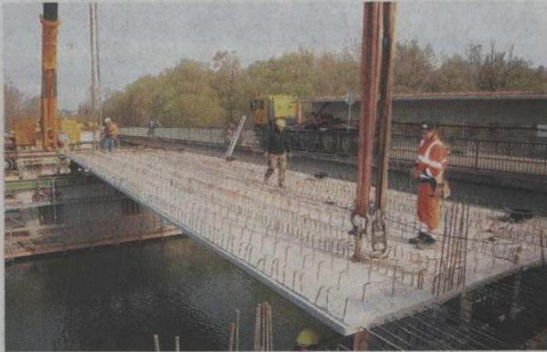
Im April 2011 erfolgte die Montage der Spannbetonfertigteile und die Herstellung der Ortbetonplatte.
